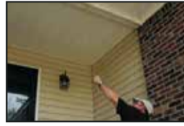
1. Mida la abertura para determinar el largo del poste.
