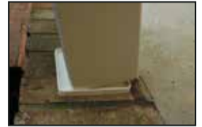
8. Coloque el poste en la placa inferior.
