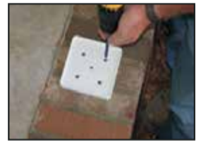
6. Coloque la placa inferior.
