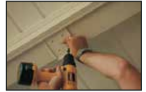
4. Instale una placa de techo
