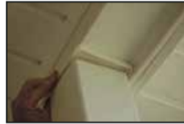
7. Sitúe la parte superior del poste con la placa superior.
