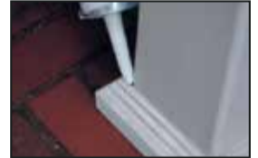
10. Deslice la pieza recortada en su lugar y aplique masilla si fuese necesario.
