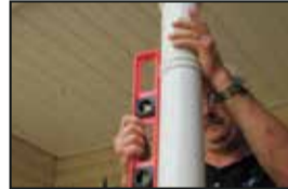
9. Revise el poste con el nivel y retire el soporte temporal permitiendo.
