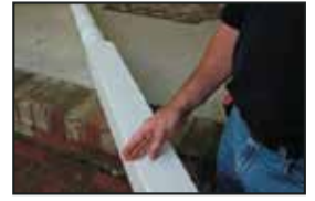
2. Determine cuánto deberá recortarse (rebaje 3/8 in. [9,5 mm] para adecuar las placas de montaje superior e inferior).
