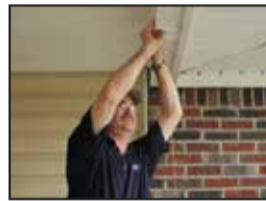
5. Utilizando una plomada, busque y marque la posición inferior en el piso
